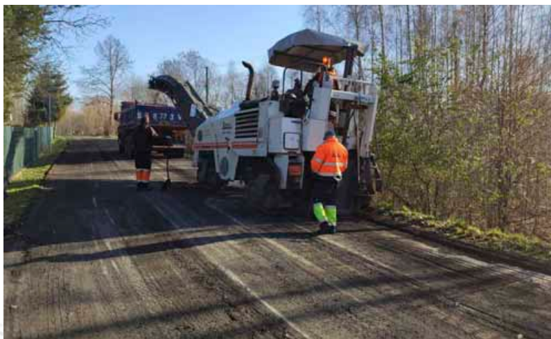
Remont ul. Jawiszowickiej
